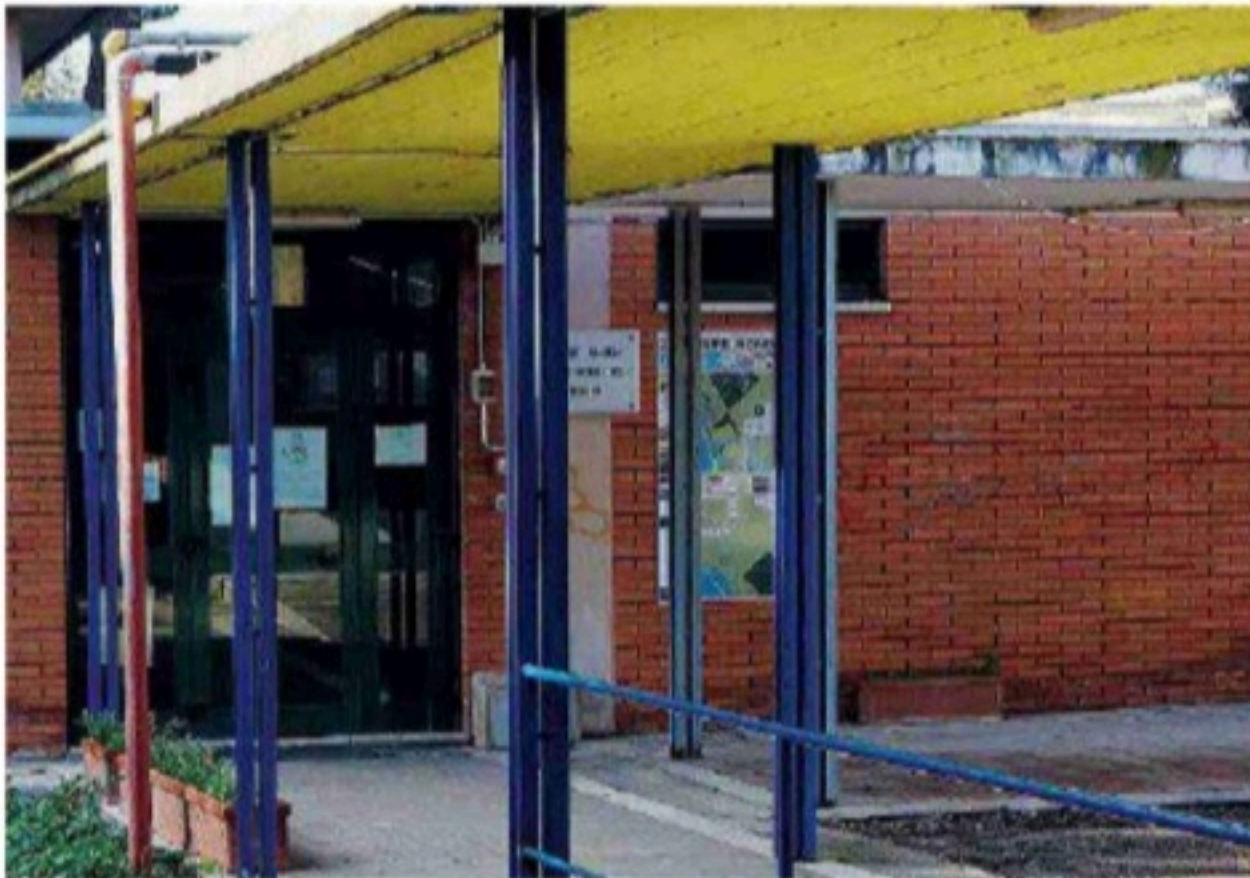
La sede centrale dell'Istituto Comprensivo Cencelli di Sabaudia
